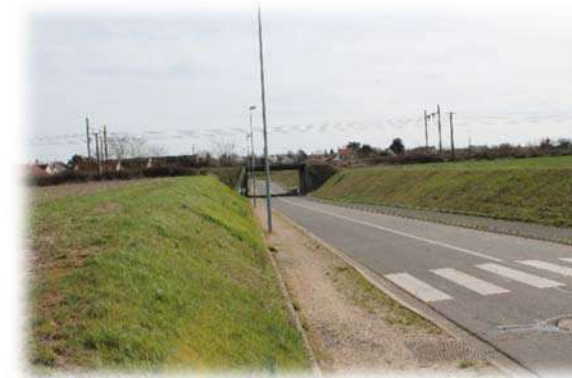
Figure 12 : photo de la rue du Clos Saint-Aignan et de la voie ferrée qui la surplombe
