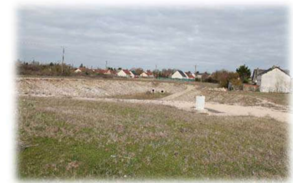
Figure 13 : photo du bassin tampon existant en limite du projet
